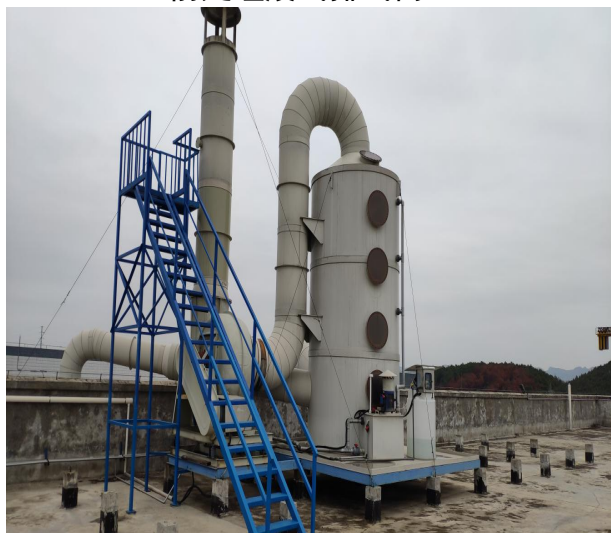
烘干、喷粉废气排气筒（DA002）
